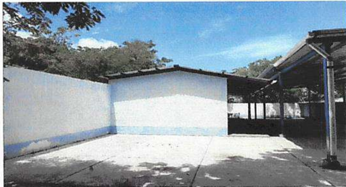
Galera e intalación de sistema electrico en galera.
